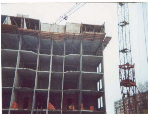
Рис. 1. Конвективный прогрев во время строительства жилого дома по ул. Гагарина в г. Челябинске
