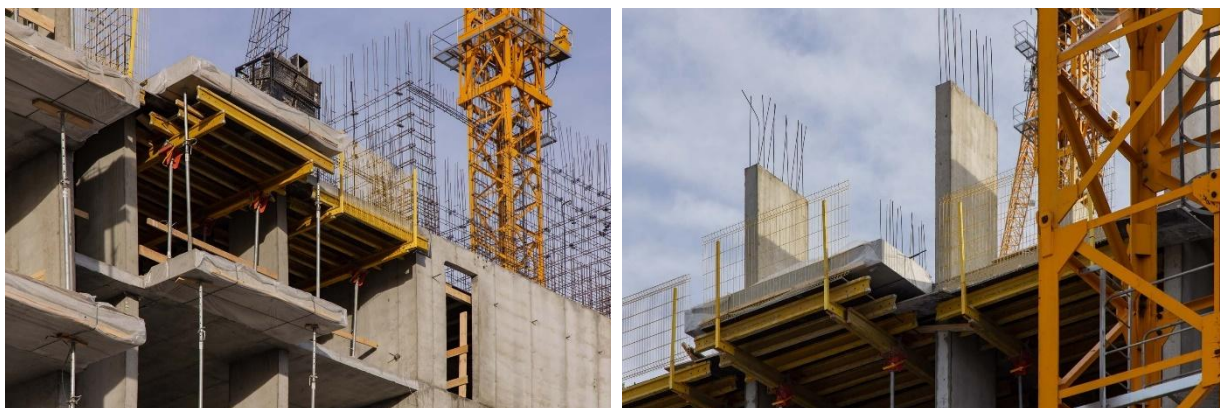
Рис. 1. Ход строительства ЖК «Депо» с применением сборных балконов
