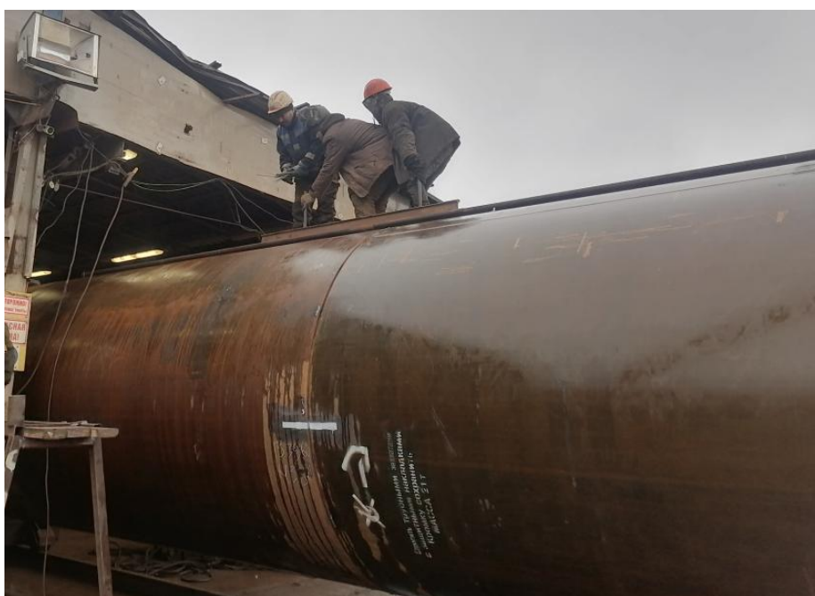
Рис. 4. Контрольная сборка сегментов ШТС Ø 2520 мм с протаскиванием шаблона замкового профиля длиной не менее 2 м и нанесением линии фиксации в месте кольцевого стыка (белой краской)
