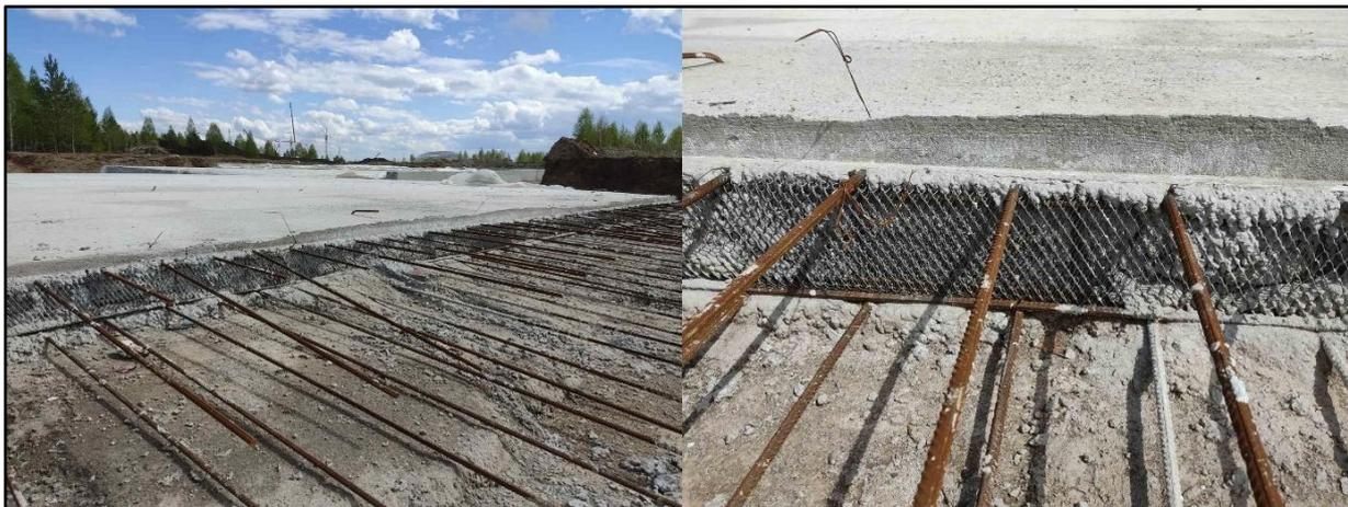
Рис. 1. Организация рабочего шва бетонирования в возводимой плите
