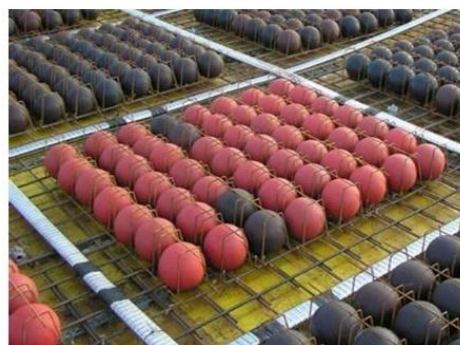
Рис. 2. Изготовление МППЛ с использованием локальных пустотообразователей
