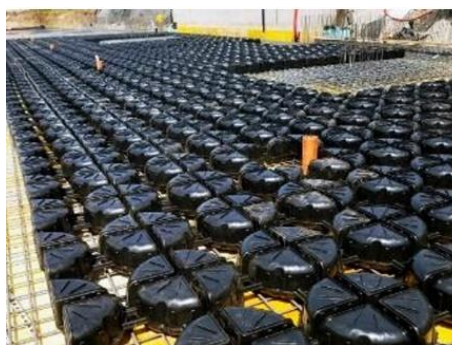
Рис. 2. Изготовление МППЛ с использованием локальных пустотообразователей
