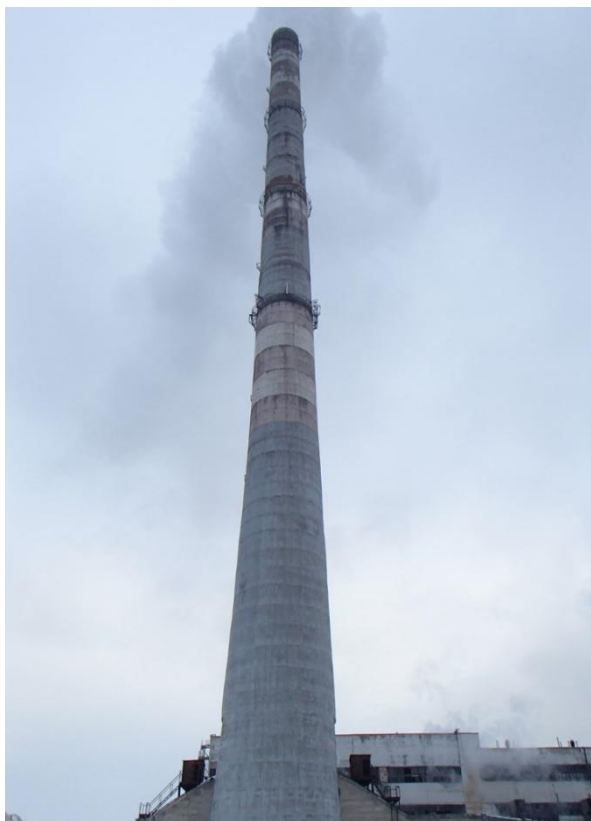
Рис. 5. Внешний вид дымовой трубы в г. Красноперекоске (Республика Крым)
