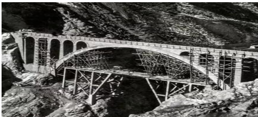
Рис. 1. Мост после строительства
