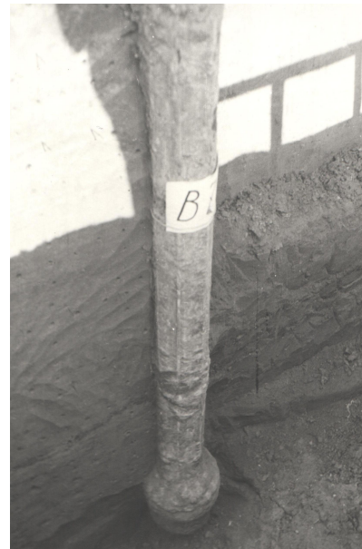
Рис. 5. Взрывофугасная свая в грунте
