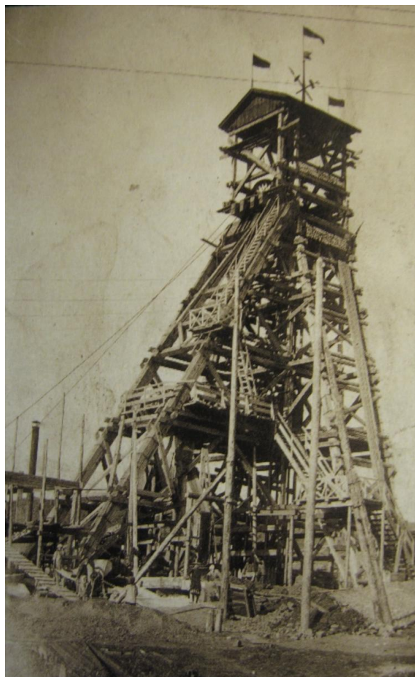
Рис. 4. Копёр на одной из первых шахт Прокопьевска. Фото из фондов Прокопьевского городского краеведческого музея
