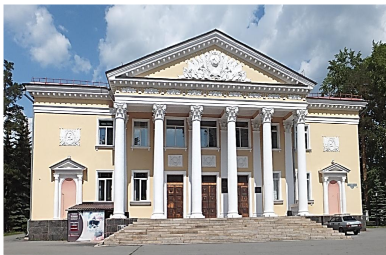
Рис. 11. Здание театра, 1949–1952 гг., арх. Б.Г. Машин. Фото Л. Михайловой, 2019 г.
