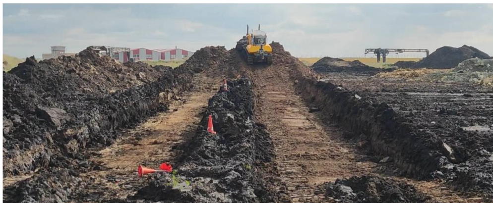
Рис. 8. Котлованы в табл. 2 и 3: 1 – слева, 2 – справа Fig. 8. Pits in tables 2 and 3: 1 – left, 2 – right
