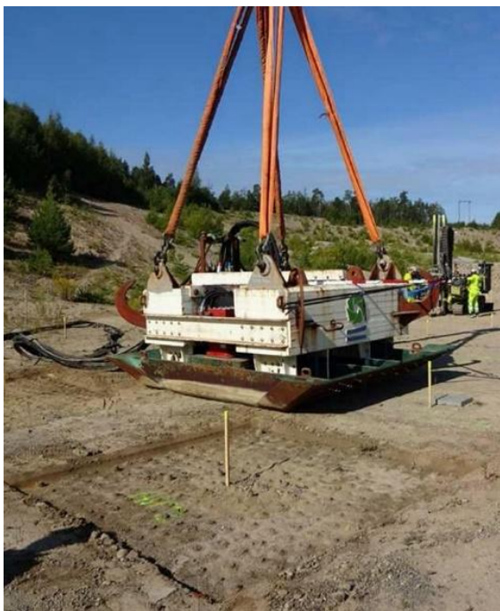
Рис. 12. Вибрационная плита общей массой 40,5 тонн и результат работы плиты Fig. 12. Vibrating plate with a total weight of 40.5 tons and the result of the plate operation
