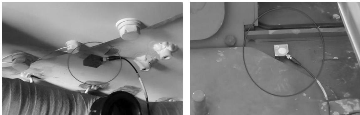
Рис. 7. Установка датчиков на крыше корпуса Fig. 7. Installing sensors on the roof of the enclosure
