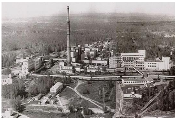
Рис. 4. Производственное объединение «Маяк» Fig. 4. Production Association «Mayak»
