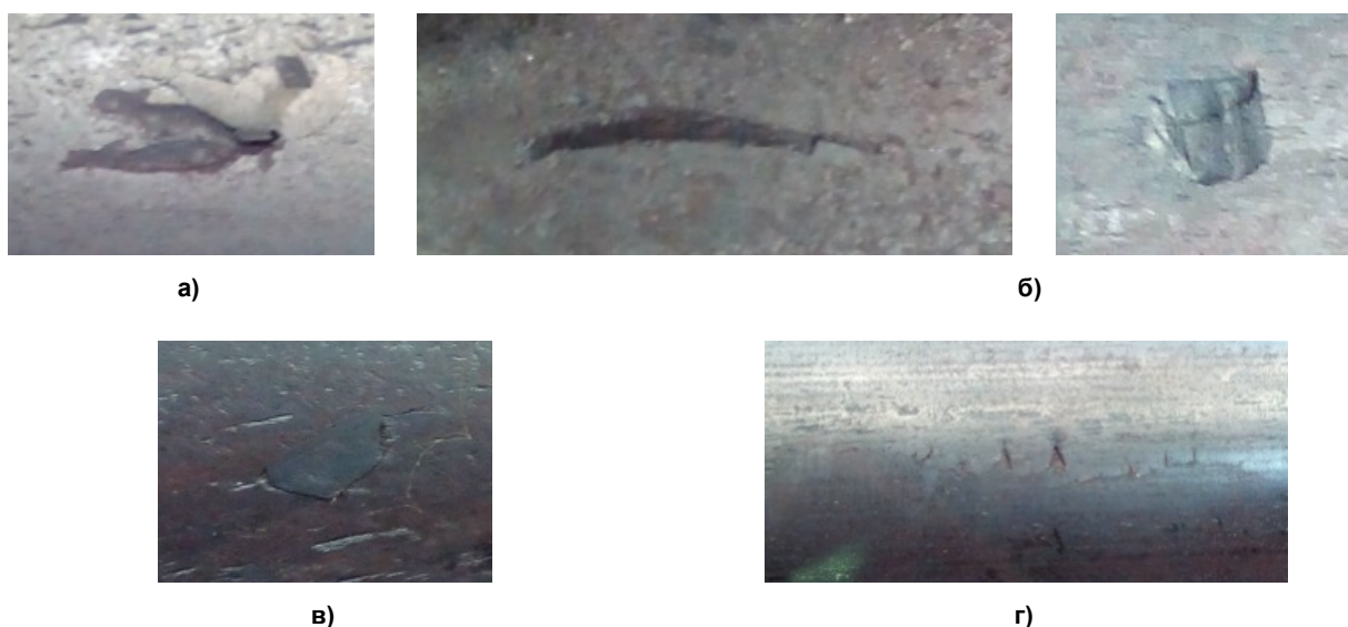
Рис. 1. Внешний вид дефектов (масштаб изображений не соблюден): а – РВ с отслоением металла; б – РВ; в – ПТ с углом соединения \approx 17^\circ ; г – ПТ длиной 80 мм вдоль образующей
