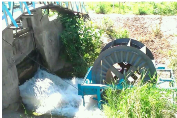
Рис. 7. Внешний вид установленного водяного колеса Fig. 7. Appearance of the installed water wheel
