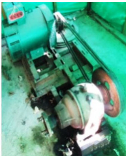
Рис. 3. Экспериментальная установка для исследования модели водяного колеса микроГЭС Fig. 3. Experimental setup for the study of the water wheel model of a micro-hydroelectric power station
